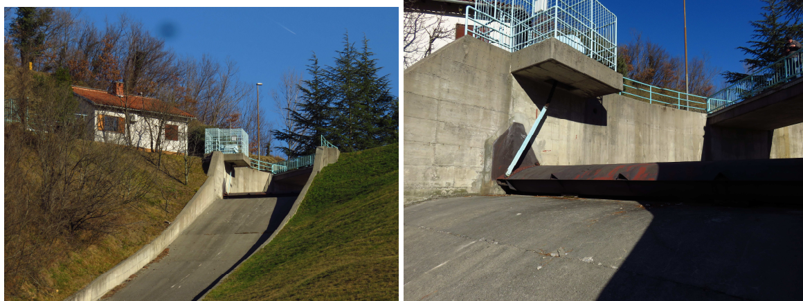
Slika 2. Preliv za visoke vode z zaklopko
