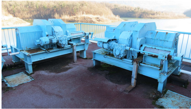
Slika 4. Dvižni pogoni finih rešetak in zapornic
